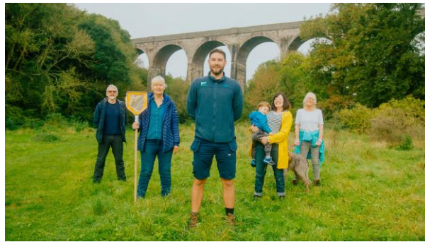
7 - Restore the Thaw
